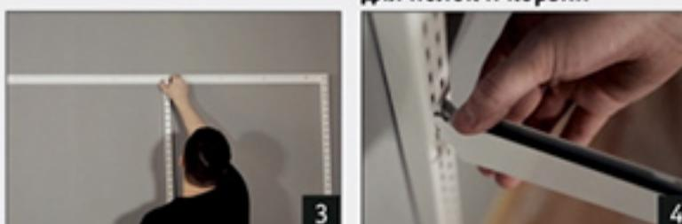
Стойка просто навешивается на рельс и, после монтажа всех элементов системы, прикрепляется к стене.
